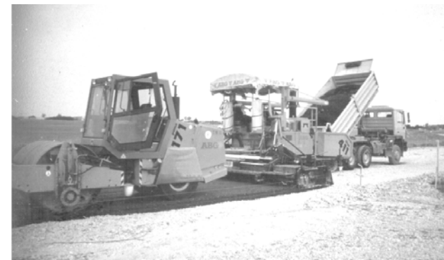
Abb. 6 Wiederverwertung von teerhaltigem Straßenaufbruch in einer Tragschicht [Wörner et al., 2001]
