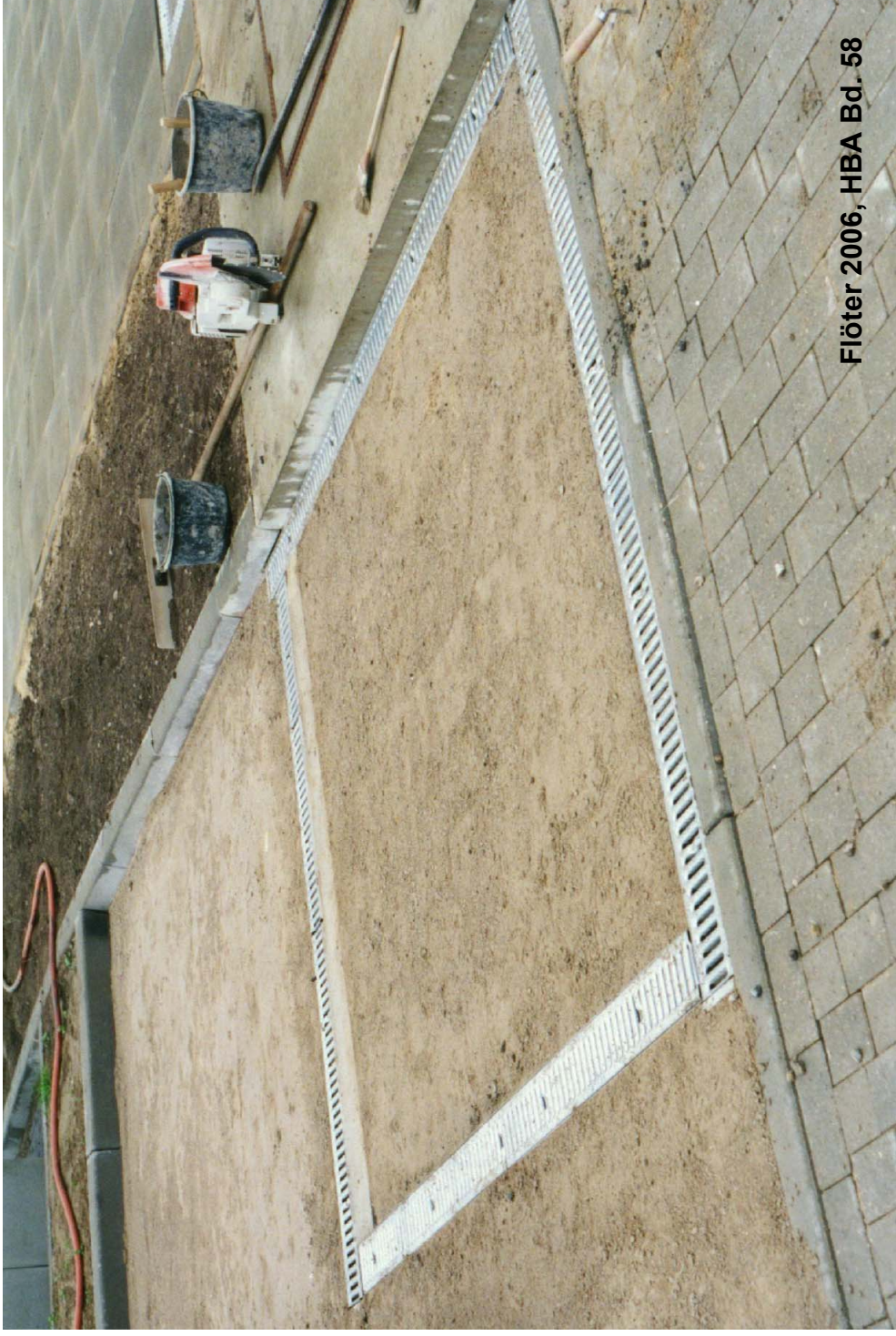
Foto 17: Lysimeteranlage Bullerdeich in Hamburg-Hammerbrook: Testfeld 2, wassergebundene Deckschicht aus Glensanda. (Aufnahmedatum 08.07.1996)
