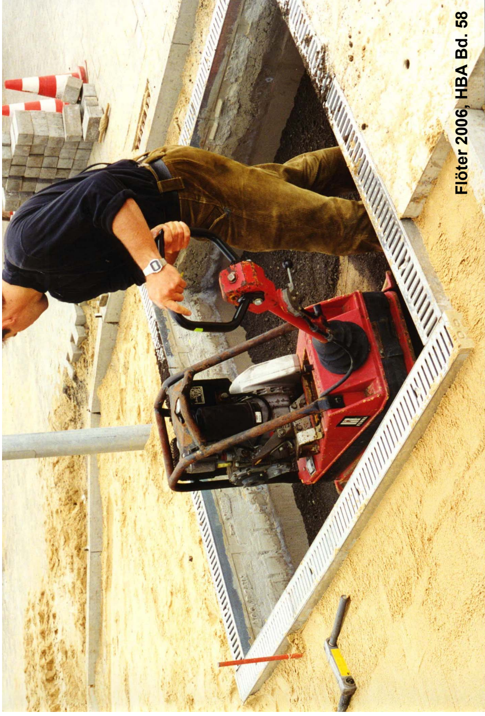
Foto 13: Lysimeteranlage Bullerdeich in Hamburg-Hammerbrook: Verdichtung der HMV-Asche 0/32 mm im Testfeld 3 mit einer reversiblen Rüttelplatte (Aufnahmedatum 08.07.1996)
