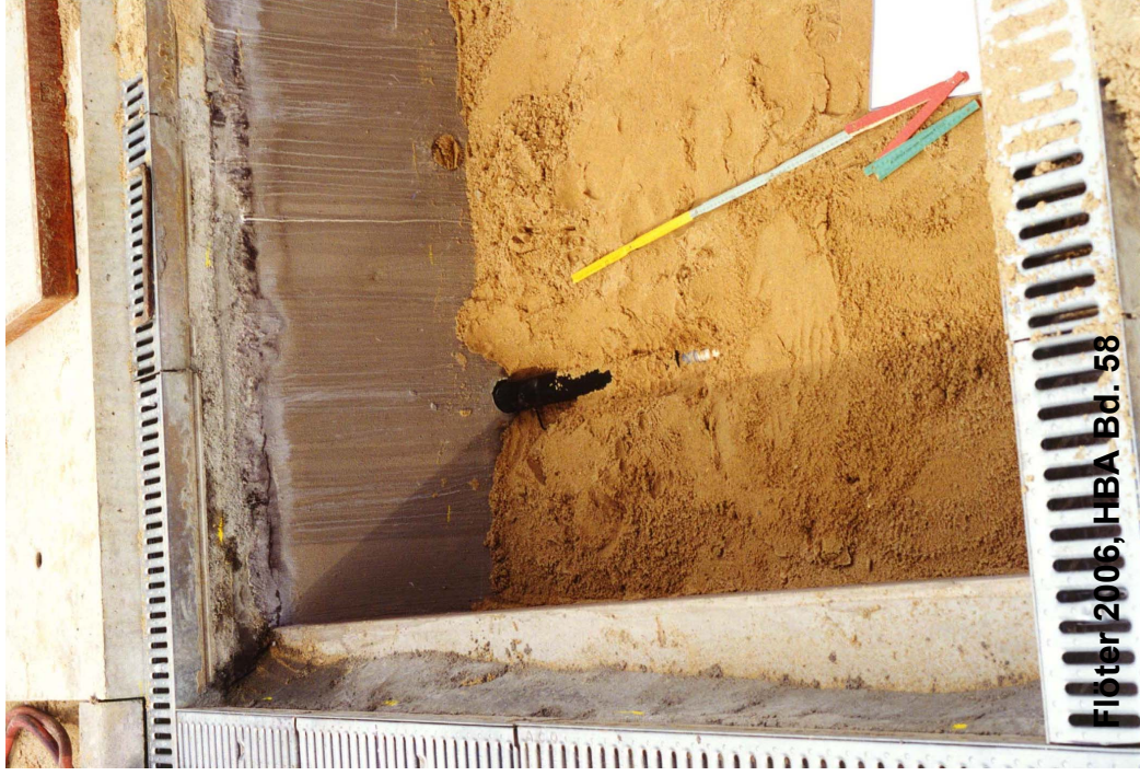
Foto 23: Lysimeteranlage Bullerdeich in Hamburg-Hammerbrook: Einbau Tensiometer mit schwarzem Führungsrohr in den Sand des Unterbaus
