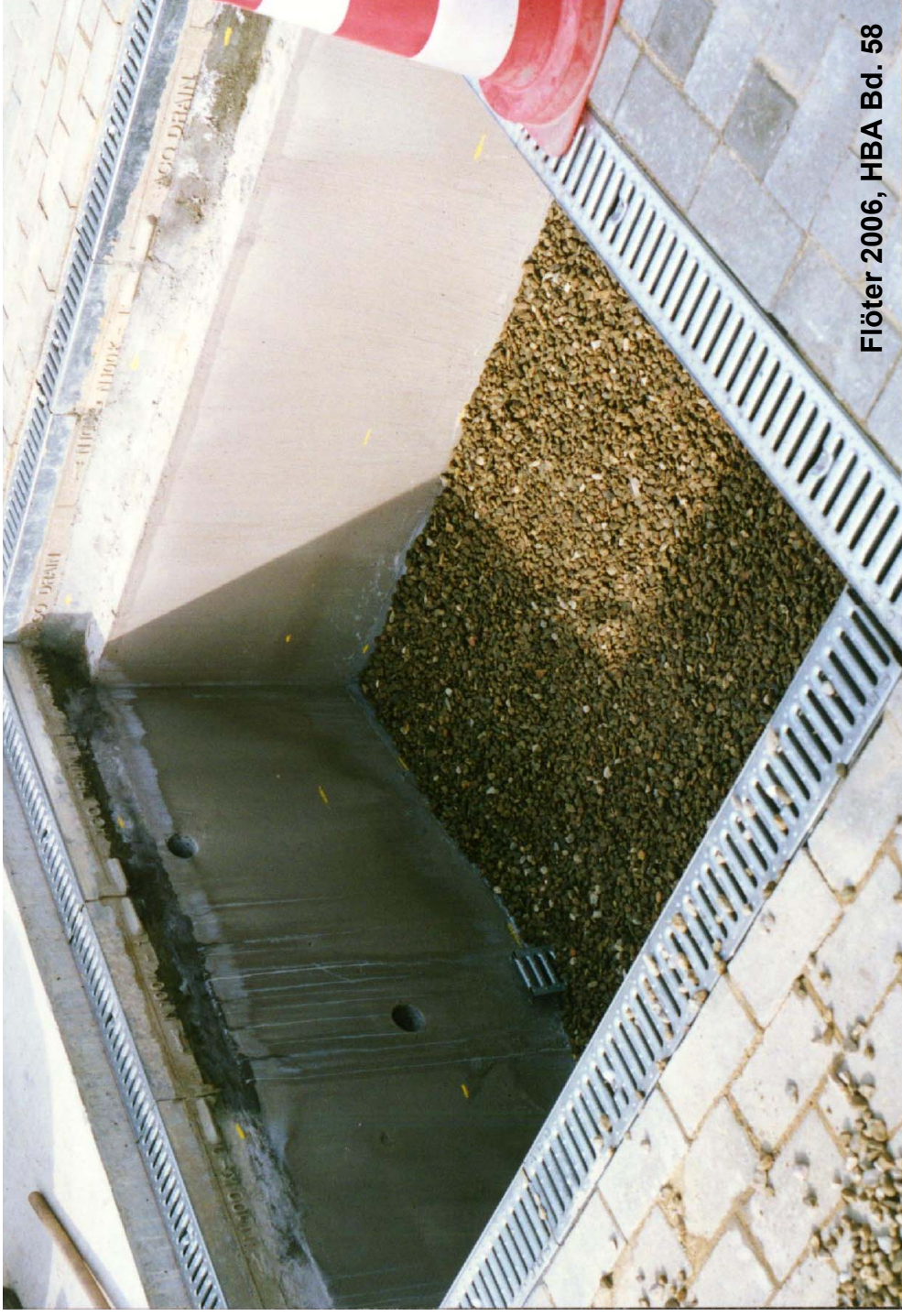
Foto 10: Lysimeteranlage Bullerdeich in Hamburg-Hammerbrook: Einbau Drainagekies im Testfeld 1 (Aufnahmedatum 08.07.1996)
