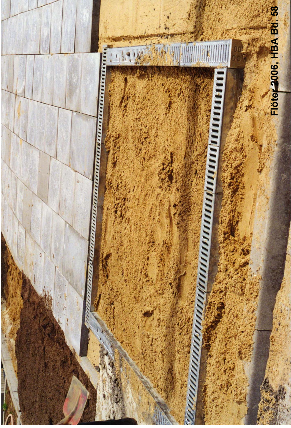
Foto 14: Lysimeteranlage Bullerdeich in Hamburg-Hammerbrook: Einbau des Plattenbetts aus Sand 0/2 mm im Testfeld 3 (Aufnahmedatum 08.07.1996)
