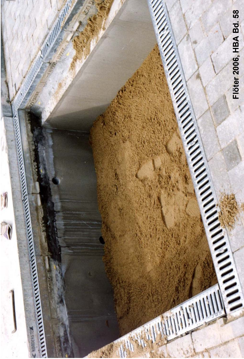
Foto 11: Lysimeteranlage Bullerdeich in Hamburg-Hammerbrook: Einbau F1-Sand des Unterbaus im Testfeld 1 (Aufnahmedatum 08.07.1996)
