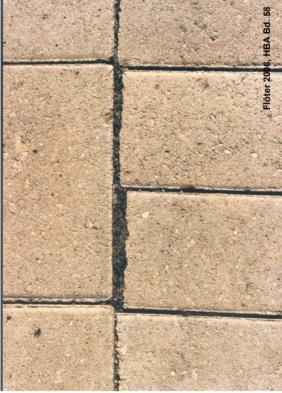
Foto 1: Testfeld 1 - Pflasterdecke aus Betonrechtecksteinen. Lysimeteranlage Bullerdeich. Die etwas breiteren Fugen (ca. 4 mm) sind nach ca. 9 Monaten mit Moosen bewachsen. Die Moose wachsen nicht über die Steinoberfläche hinaus, da die Befahrung den Wuchs in die Höhe einschränkt (Aufnahmedatum Juni 1997)
