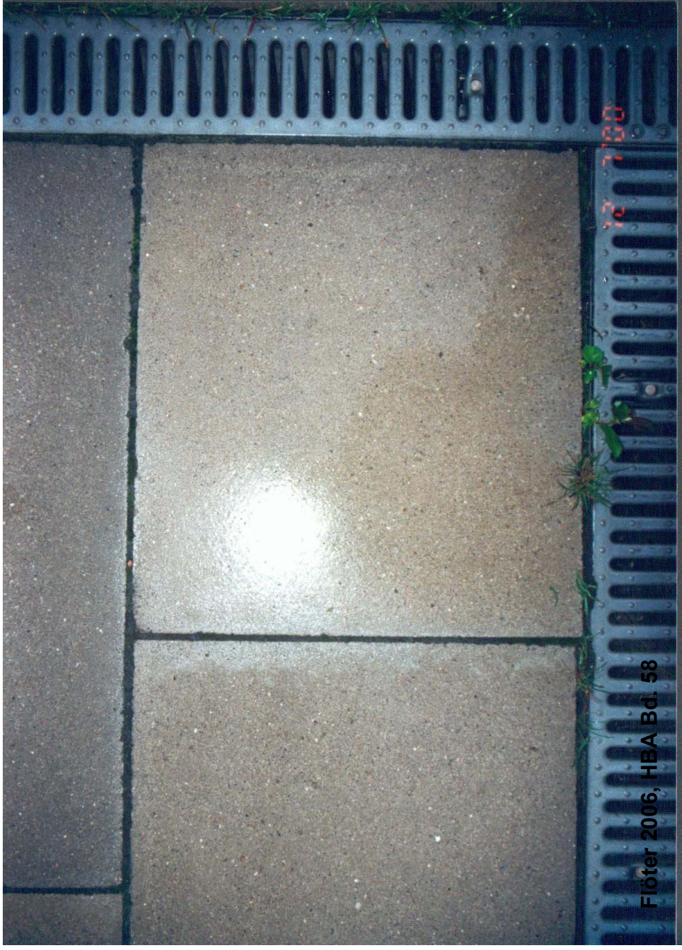
Foto 10: Testfeld 3 - Plattenbelag. Lysimeteranlage Bullerdeich. Die Fugen sind ca. 48 Monate nach der Herstellung überwiegend mit Moosen und z.T. mit Gräsern und kleinen Pflanzen bewachsen (Aufnahmedatum 12.07.00)
