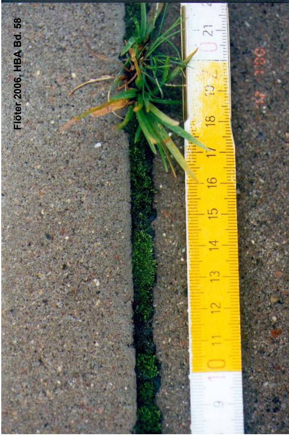
Foto 11: Testfeld 3 - Plattenbelag. Lysimeteranlage Bullerdeich. Detailaufnahme einer Fuge 48 Monate nach der Herstellung. Die Gräser nahmen zu diesem Zeitpunkt ca. 10% der Fugenfläche ein (Aufnahmedatum 12.07.00)
