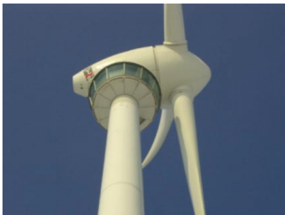
Die Besichtigungsplattform einer Windenergieanlage in Westerholt
